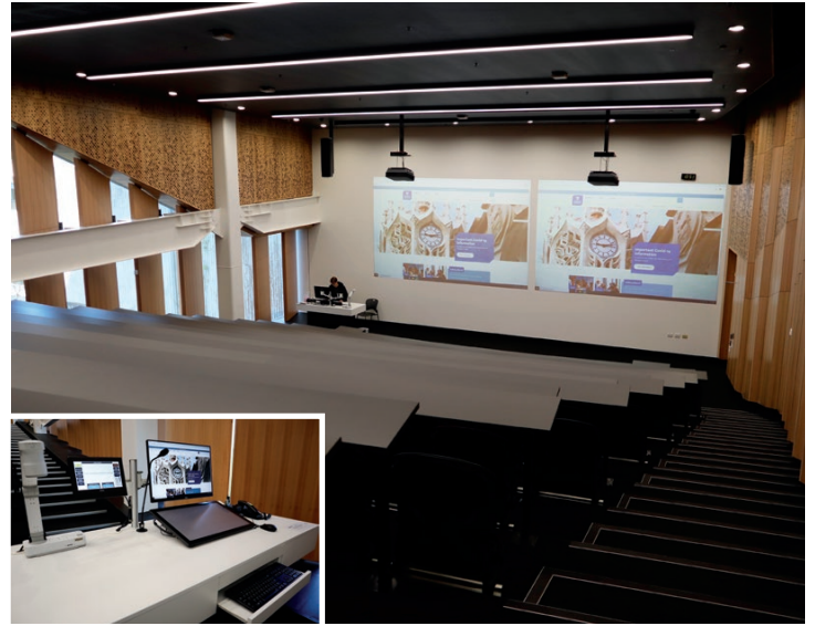
报告厅，左下方小图为集成 PC、实物展台、用于添加注解的平板电脑、触摸屏控制界面以及麦克风的讲台
