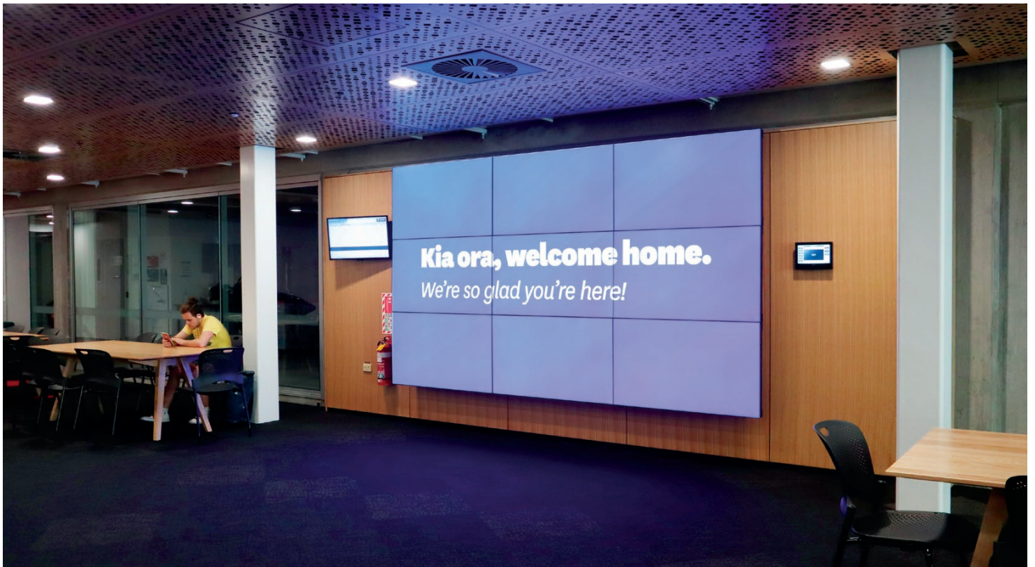
中庭配备的视频拼接墙用于演示公众关注度较高的信息。同学们可使用安装在拼接墙右侧的 TLP Pro 触摸屏选择播放大楼内所有教室及报告厅的信号源内容，并通过拼接墙观看
